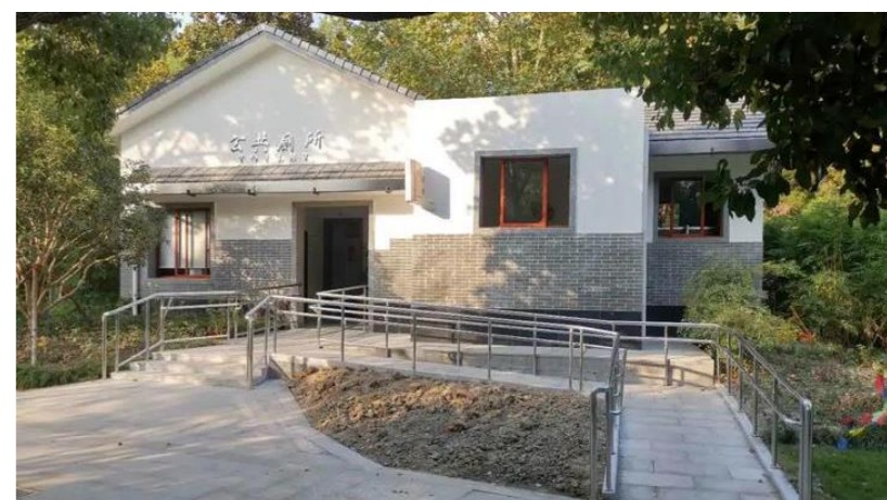
入口设置无障碍坡道
