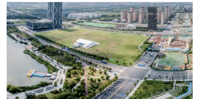
常州高铁新城建设全面开启
